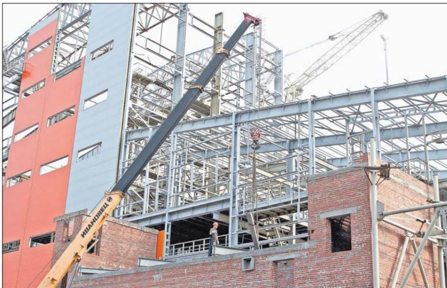
Строительство газоочистки в агломерационном цехе метзавода.
